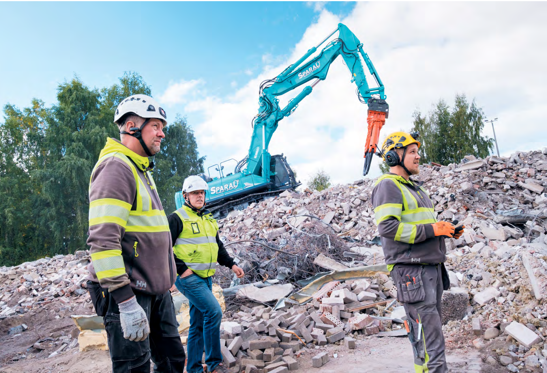
Pohjoismaiden suurin Kobelco-purkumonsteri oli käytössä Perkkäällä. Koneen erikoisuus on pitkälle ulottuva puomi, kertovat Sparal Oy:n Sami Tarkkanen, Mikael Sparf ja Joona Salo.
