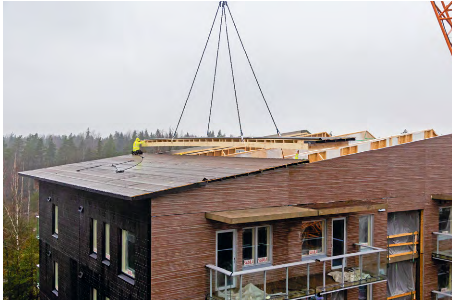
Kattoelementeillä rakennus saadaan suojaan jopa nopeammin kuin perinteisellä sääsuojalla, kertoo KerabitPron liiketoimintajohtaja Ari Hoikkala.
